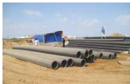
Các công trình thoát nước của công ty cấp nước Bình Dương Drainage Construction Binh Duong
