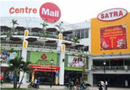
CENTRE MALL – PHẠM HÙNG Sàn sân khấu, rạp chiếu phim
