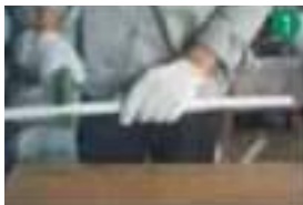
Cắt ống theo chiều vuông góc bằng hoặc dụng cụ chuyên dùng
