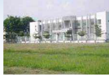
KHU CÔNG NGHIỆP LÊ MINH XUÂN Bình chánh – Tp.HCM Sàn nhà xưởng, sàn cách nhiệt, sàn nâng
