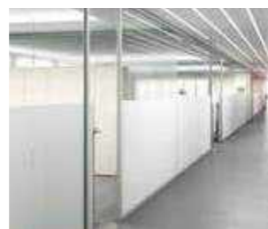
Vách ngăn nhà xưởng chống cháy
