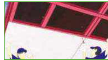
Cho khung gỗ và khung chữ C: Sử dụng vít chìm, kích thước 1 inch. Cho khung thép: Sử dụng vít chìm, đầu kim cương
